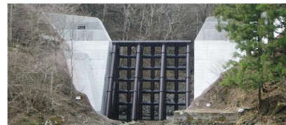
図4-11 滝ノ沢砂防堰堤 出展:利根川水系砂防事務所HP
