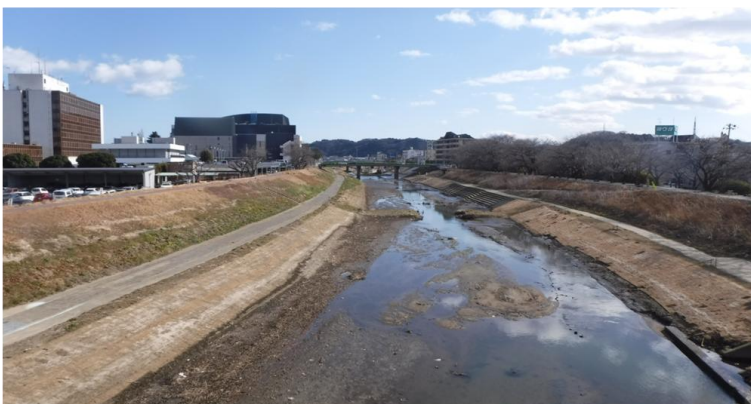
図5-2(1) 夏井川水系新川下流堤防(土堤防)
